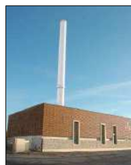
Chaufferie bi-énergies bois et gaz
